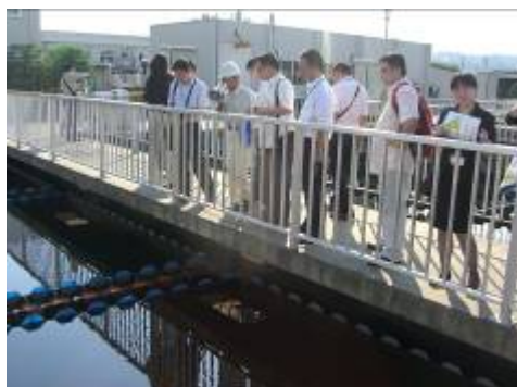
長野県内の浄化管理センターを視察する 中国メディア関係者
